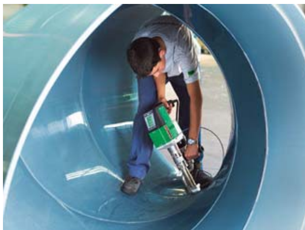
Рис.3.4. Экструзионная сварка внутреннего шва полимерной трубы
