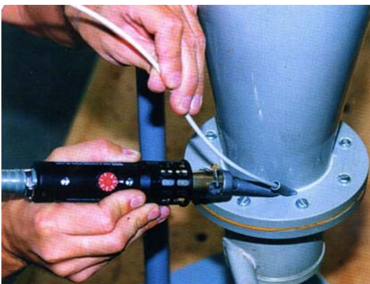
Рис.2.13. Сварка конструкции из пропилена аппаратом ЛАБОР S с насадкой быстрой сварки фирмы Ляйстер
